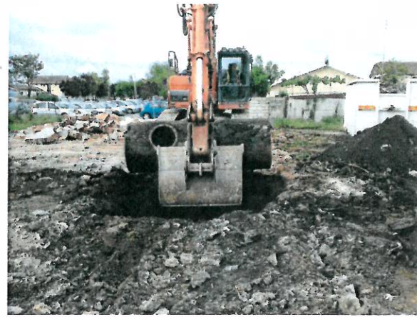
Dépose d'une des cuves
