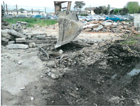
Démolition du dallage situé sur les cuves enterrées
